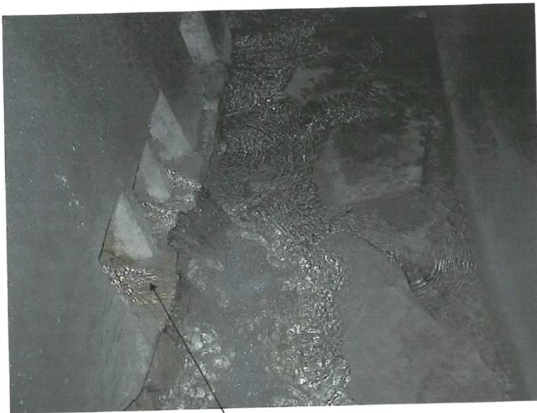
Arrivées d'eau captées par des regards maçonnés dans la galerie
