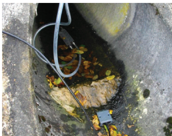
Crépines et détecteur de surverse
